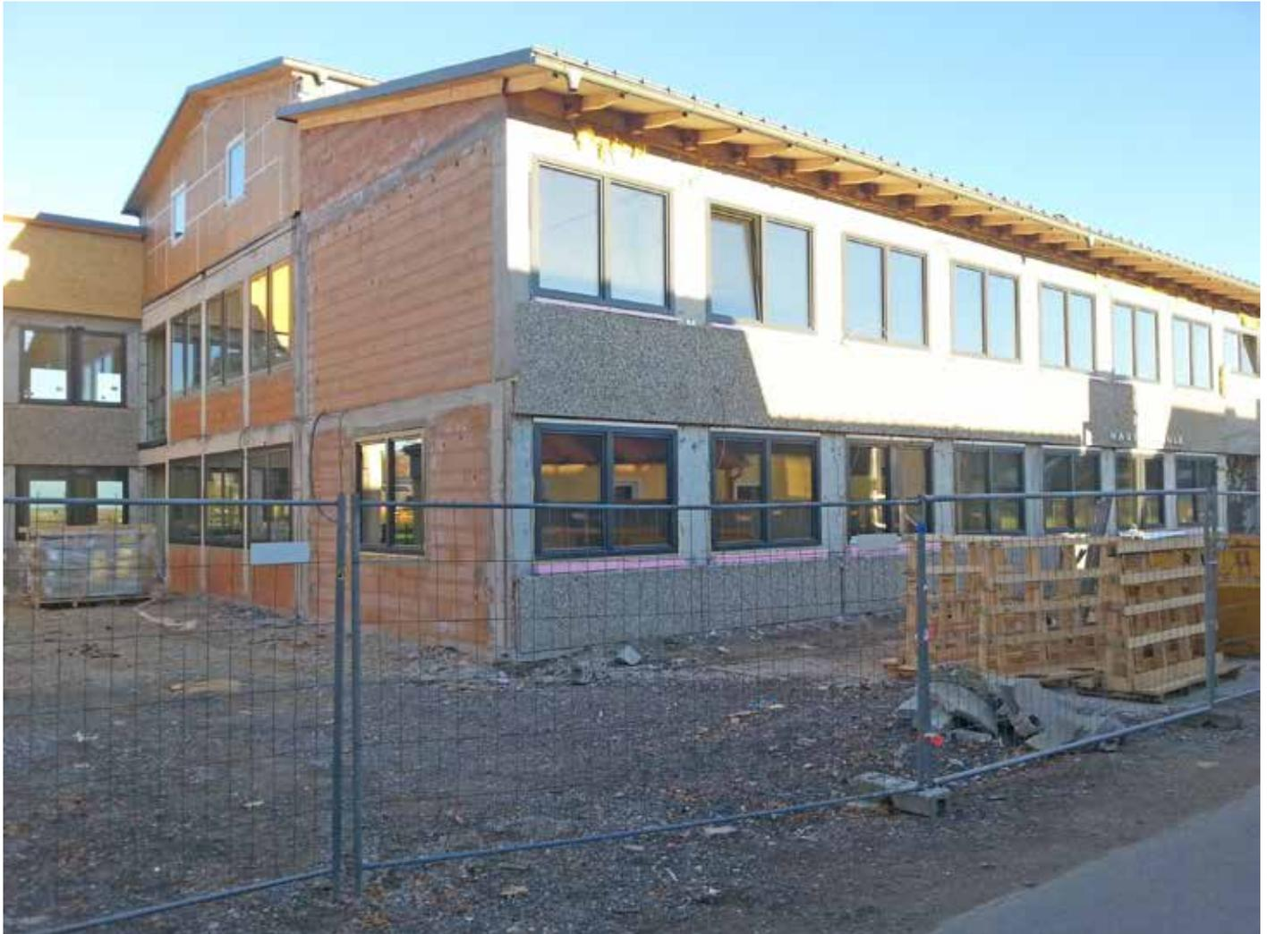
**Momentan wird der Altbau der NMS vollkommen renoviert. Derzeitiger Baufortschritt beim Altbau: Dach, Fenster, Abwasser, Kanal, Zwischenwände mauern und Elektroinstallation.**
